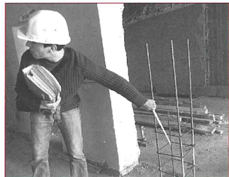
Chaque mardi matin le maire et les responsables des travaux évaluent l'avancée du chantier de l'ancienne gendarmerie.
