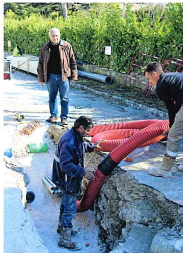
L'enfouissement des réseaux électricité téléphone eaux et fibre se poursuit au quartier du Laquet après celui la Romane et du Haut Laquet. Ces travaux permettent d'enlever les poteaux et de reprendre et d'améliorer les transmissions existantes.
